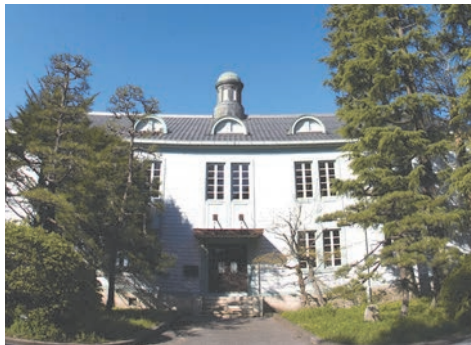
耐震改修が認められた講堂
